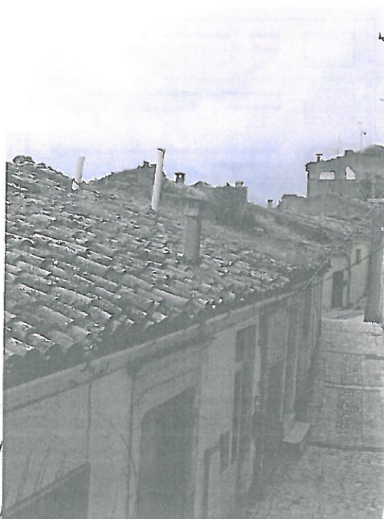
Foto 4 – Vista della cortina del fabbricato
