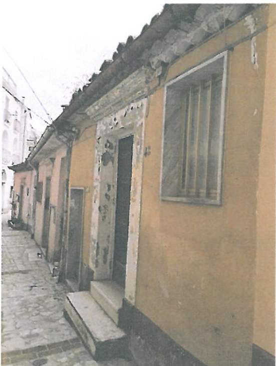
Foto 1 – Vista dell'ingresso al piano terra
