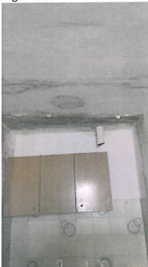
Solaio sottotetto in cucina
