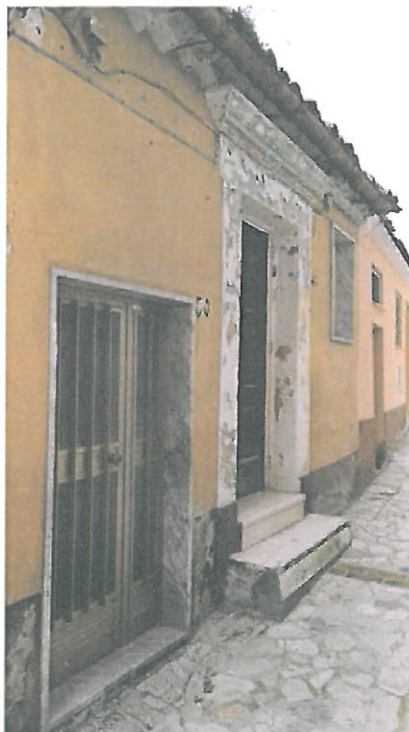
Foto 2 – Vista dell'ingresso al piano seminterrato
