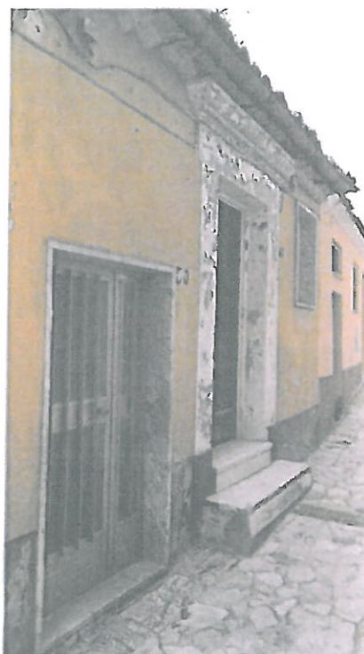
Foto 2 – Vista dell'ingresso al piano seminterrato
