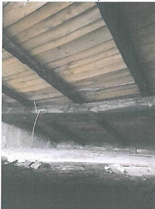
Situazione del resto del solaio
